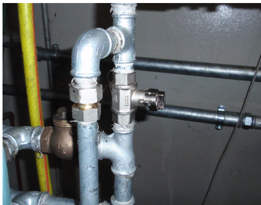
Valvola prova d'allarme del tipo "antimanomissione"
