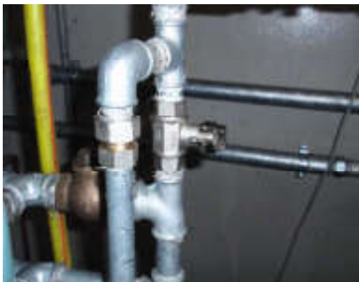
Valvola prova d'allarme del tipo "antimanomissione"
